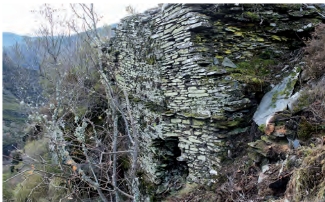
Muralla para la sustentación del terreno en el Castro de Seceda.
