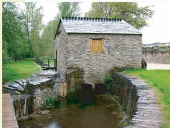
O muíño do Xil (Bóveda) está reconstruído
