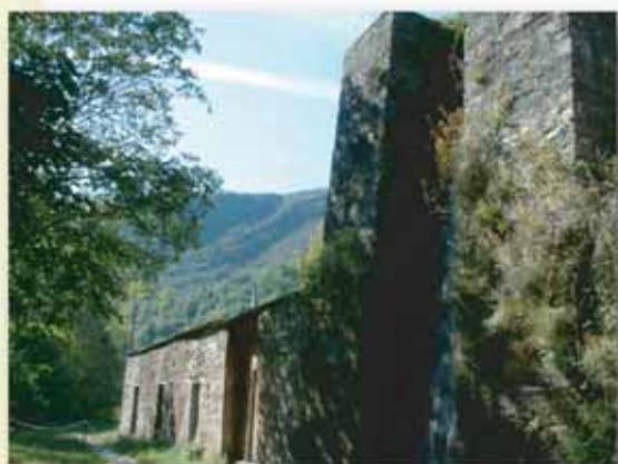
Edificio da ferraría recuperada en Ferrería Nova, Seoane (Folgozo do Caurel)
